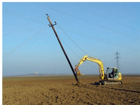
V Rakousku se díky podpoře z programu LIFE podařilo ve třech oblastech s výskytem dropa velkého převést 47,4 km elektrického vedení na zemní kabelové vedení a označit 153 km velmi vysokého napětí. Foto: Rainer Raab
